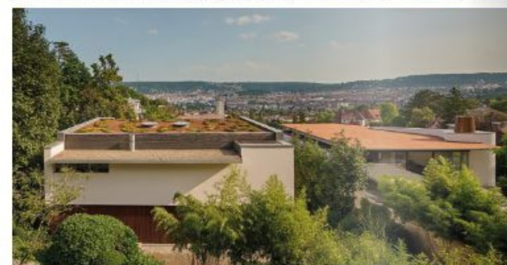
Links das Haus Rudolph 1 von 1997 und rechts das Haus Rudolph 2 aus dem Jahr 2021.
